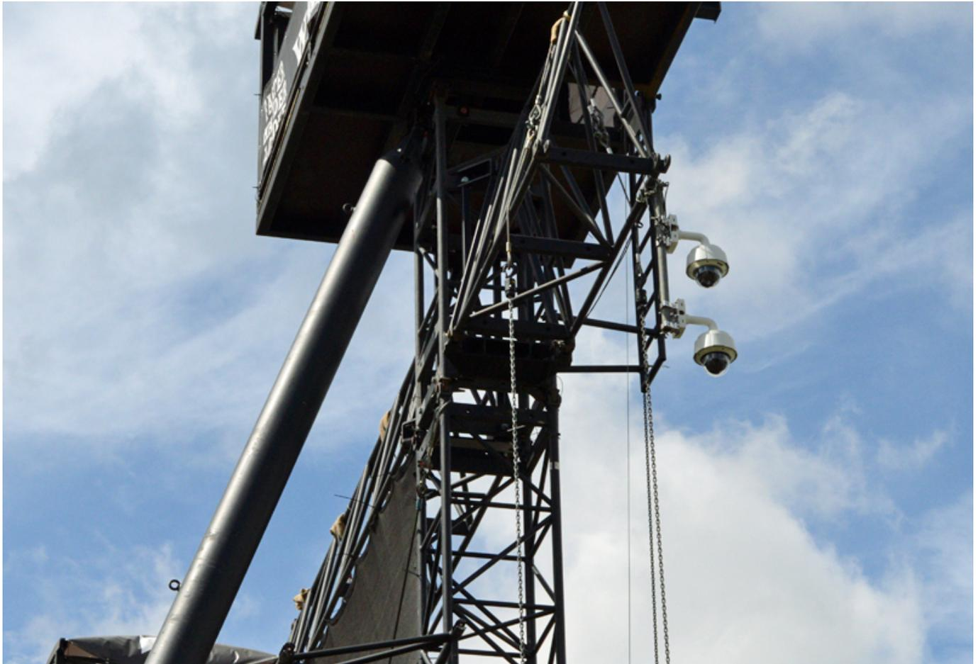
Eine weitere Forderung ist, dass das gesamte Veranstaltungsgelände visuell überwacht werden soll. Hierfür wurden im Innenbereich 26 Dome-Überwachungskameras von AXIS mit Schwenk-Neige-Zoom-Funktion (PTZ) installiert, die über das MediorNet-Glasfasernetzwerk verbunden sind. Eine Forderung ist auch, dass die Kameras müssen über eine gute Restlicht-Auflösung verfügen. In einem Kontrollraum werden die Bilder dann ausgewertet.
