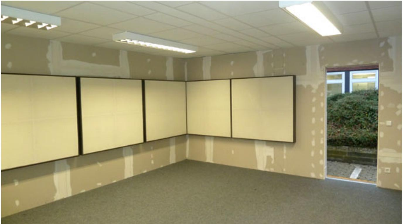
Der Frequenzgang von 45 Hz bis 20 kHz lag im Bereich von +/- 2 dB. Die Nachhallzeit lag unter 0,4 Sekunden. Durch die massive akustische Dämmung des Doppelgehäuses verursachten selbst die tief überfliegenden Passagierflugzeuge im Studioinnenraum keine Beeinträchtigungen. Die akustische Außendämmung war auch deutlich höher als in den Ü-Wagen.
