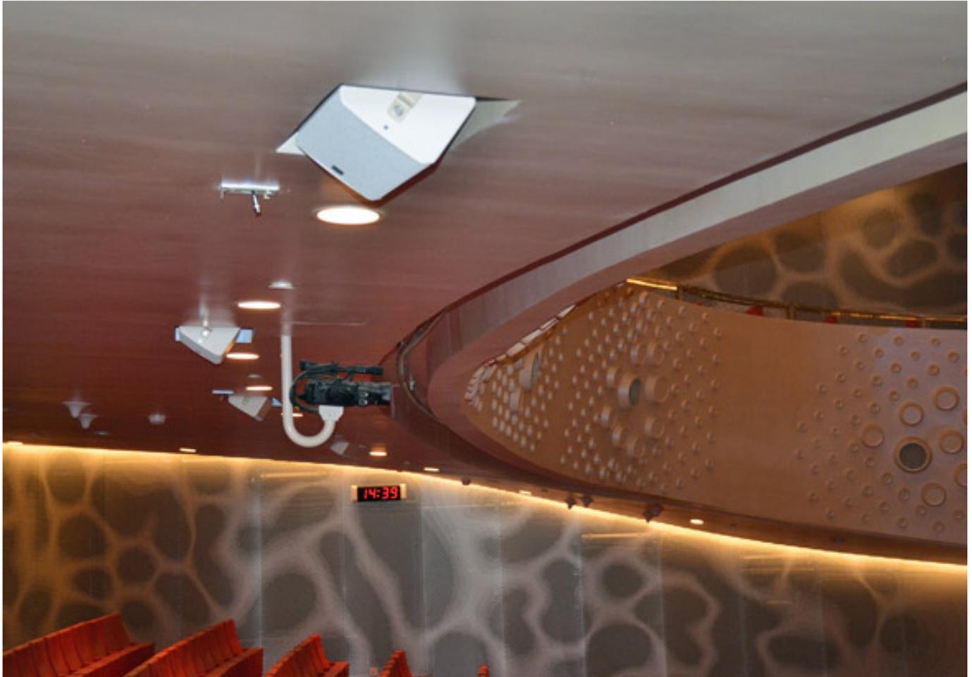
20 Stück K&F CA 106 sind unter den Balkonen installiert, um den Bereich der Klagschatten abzudecken. Fünf K&F CA 1215 Full-Range-Lautsprecher und drei K&F SWi 115E Subwoofer sind an der Decke des Theaters vertikal aufgehängt, um Effekte wie die Stimme von Gott zu realisieren. Alle Lautsprecher in Kombination bilden einen akustisch perfekten 360-Grad-Hall-Effekt im ganzen Auditorium, der fast wie der natürliche reflektierte Schall wahrgenommen wird.
