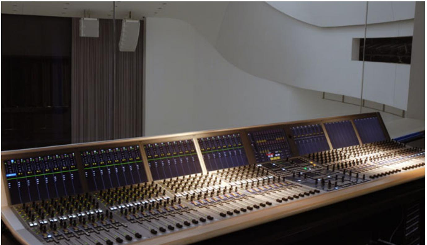
Im Mittelpunkt des Audiosystems stehen ein digitales Mischpult des Typs CRESCENDO von STAGETEC mit 56 Fadern sowie ein NEXUS STAR Router, beide in der Tonregie des großen Saals installiert. Das Pult kann allerdings auch an anderer Stelle im Haus eingesetzt und über die im Haus vorhandenen Glasfaser-Wege an den STAR-Router angebunden werden, so dass beispielsweise eine Nutzung als
