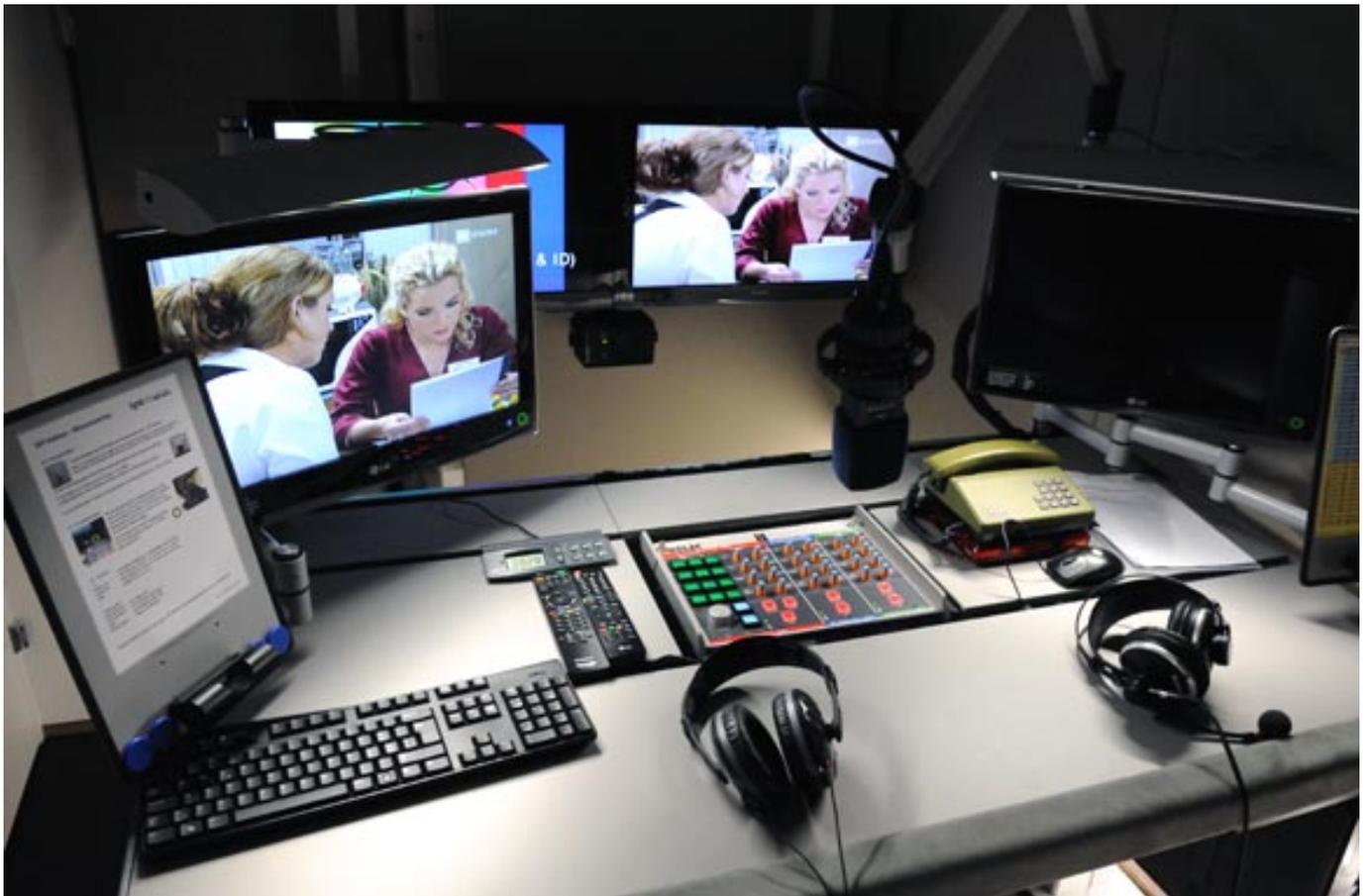
In Zürich wurden im Dezember 2010 zunächst zwei neuen Kommentatorenkabinen fest installiert. Weitere werden aber noch folgen. Das werden bis zu acht Kabinen sein. Hier finden die Kommentatoren dieselbe Technik wie bei den Kommentatorenplätzen vor Ort bei den Sportveranstaltungen. In der Kommentatorenkabine gibt es hier drei Mikrofoneingänge: zwei Headsets und einen für ein Großmembranmikrofon. Dadurch lassen sich diese beiden Plätze auch für Radioapplikationen einsetzen.
